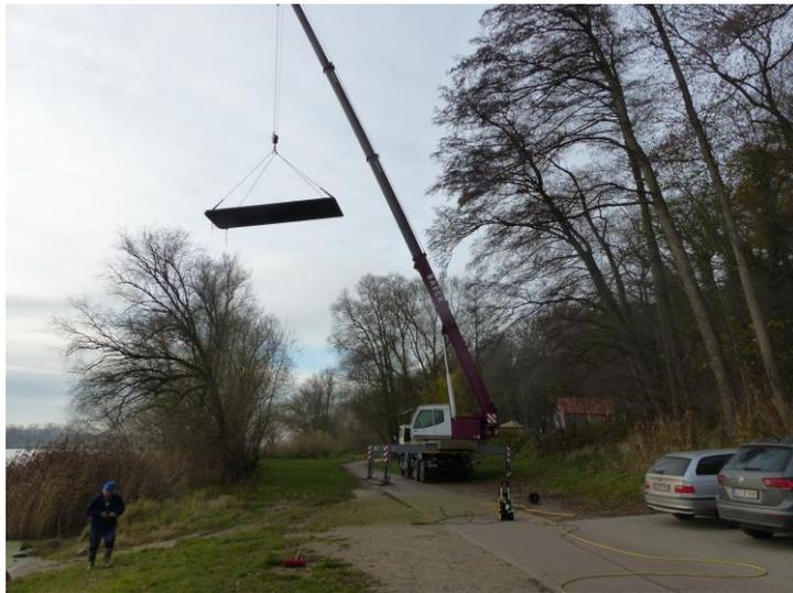
Foto 3: Der Autokran schwenkt das Stegsegment zum Lagerplatz
